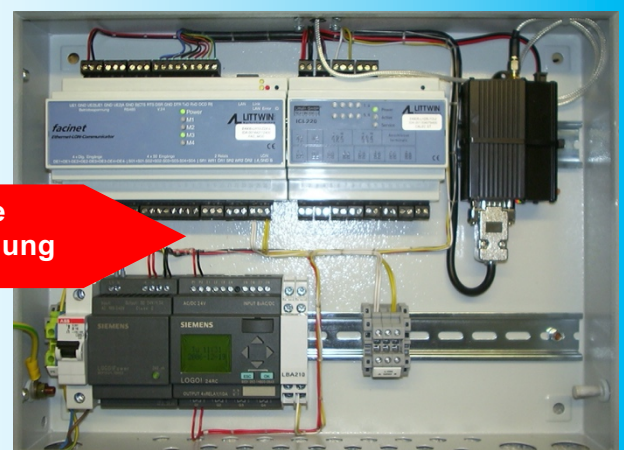
Facinet-System im Schaltschrank
